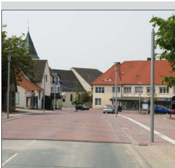
Übergang von der alten zur neuen Straßenraumgestaltung
