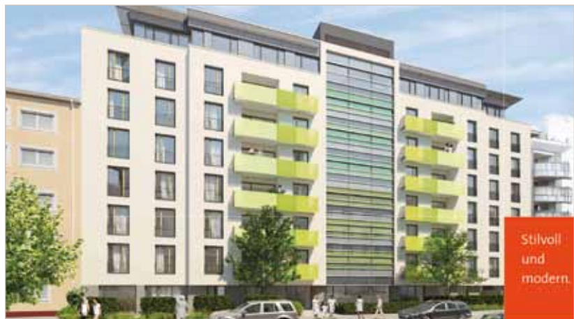
Abb. 3: Umnutzung von Büro- zu Wohnräumen in Frankfurt, Kölner Straße
