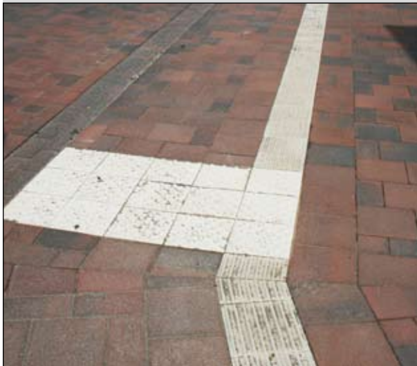
Orientierungs- / Querungshilfe für Sehbehinderte (Noppensteine)
