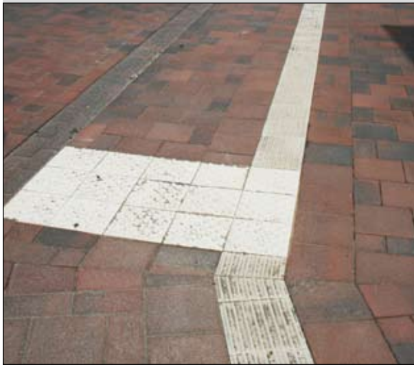
Orientierungs- / Querungshilfe für Sehbehinderte (Noppensteine)
